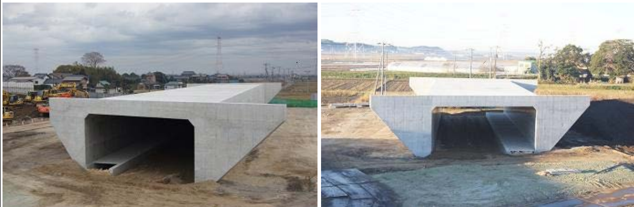
完成又は施工状況写真
